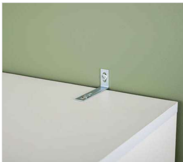
крепление шкафа к стене
